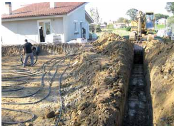
Colocación de captación horizontal y zanja del pozo canadiense-provenzal
