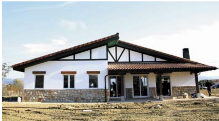
Vivienda en su última fase de construcción
