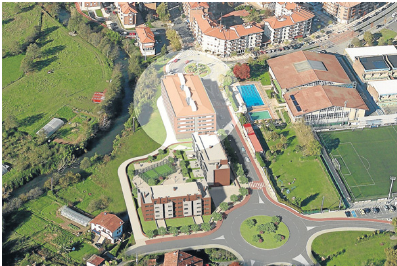
Las 48 viviendas de protección oficial que se construirán en Gamiz Bidea dinamizarán la zona. FOTO: LEIRE URÍA
