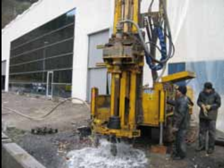
Perforación junto a la fachada del edificio terminado
