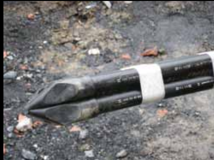
Extremo de uno de colectores geotérmicos mediante los que se realiza el intercambio de calor (sondas de doble U, compuestas por cuatro tubos y sus correspondientes uniones)
