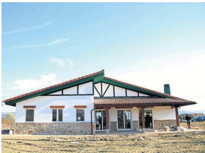
Vivienda ecoeficiente con Certificado Energético A ubicada en Laukariz (Mungia). FOTOS: VAILLANT
